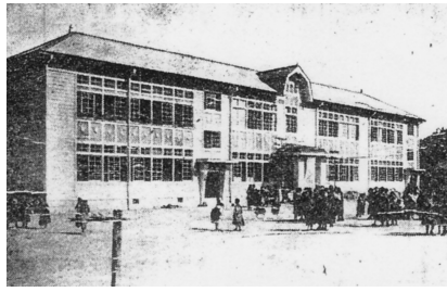
図7 旧仁堀尋常小学校
