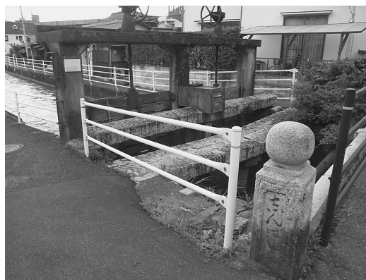
写真7 新橋と樋門（南方3丁目）
