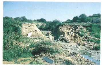
ため池の堤防中央部決壊(和気町和気)
